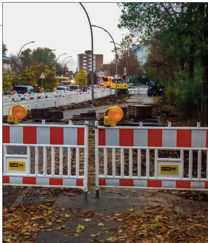
Die Bäume sind bereits gefällt, nun geht es weiter mit dem Bau der Haltebuchten auf der Neuköllner Straße gegenüber dem Hanfgraben.
