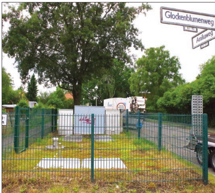
Die zentrale Anlage am Glockenblumenweg soll 2021 abgeschaltet werden, zudem ist sie nach 20 Jahren Nutzung allmählich marode.
